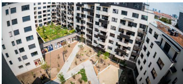
Rezidenčný komplex vo výstavbe. Foto: Corwin/Juraj Pražanka
